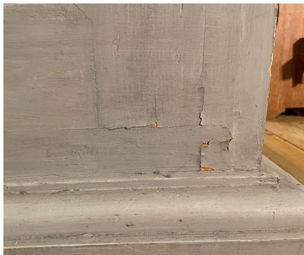
Feuchtigkeitsschäden im Gehäuse.
