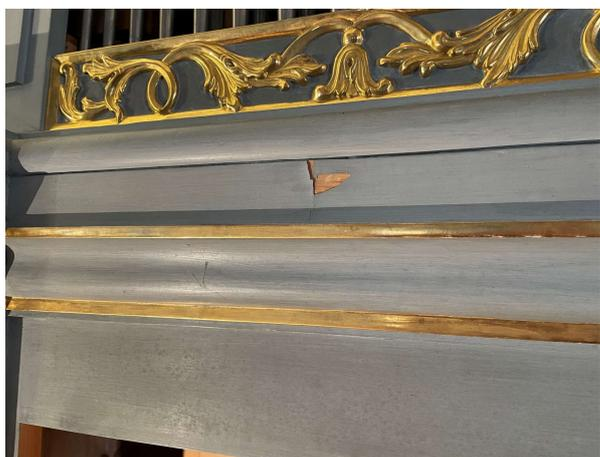
Beschädigung am Gehäuse und Schimmelflecken unter der Farbe.
