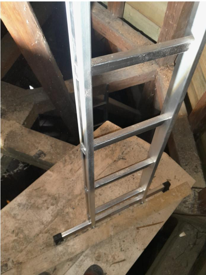
Die Leitern wurden durch Aluleitern ersetzt sowie die Podeste erneuert und erweitert für einen sicheren Aufstieg.
